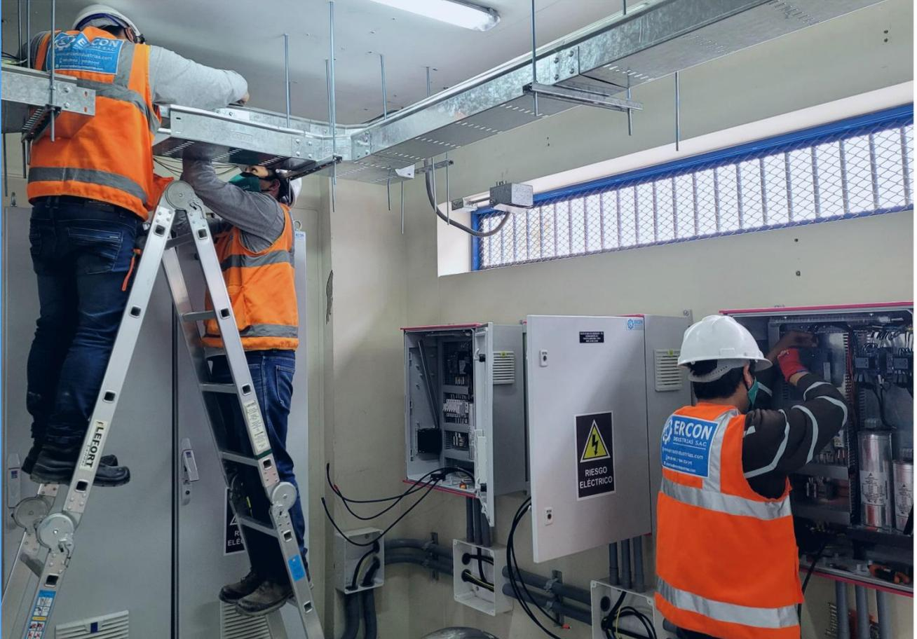
Adicionalmente se realizan mantenimientos preventivos y correctivos a tableros ya instalados de su planta, con un diagnóstico y solución a fallas en sus sistemas eléctricos y de automatización.
